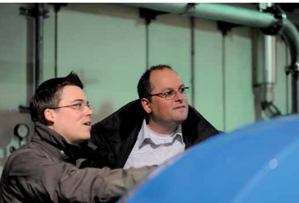
11.15 Uhr, Pumpenhaus: Kontrollgang durch das Pumpenhaus.
