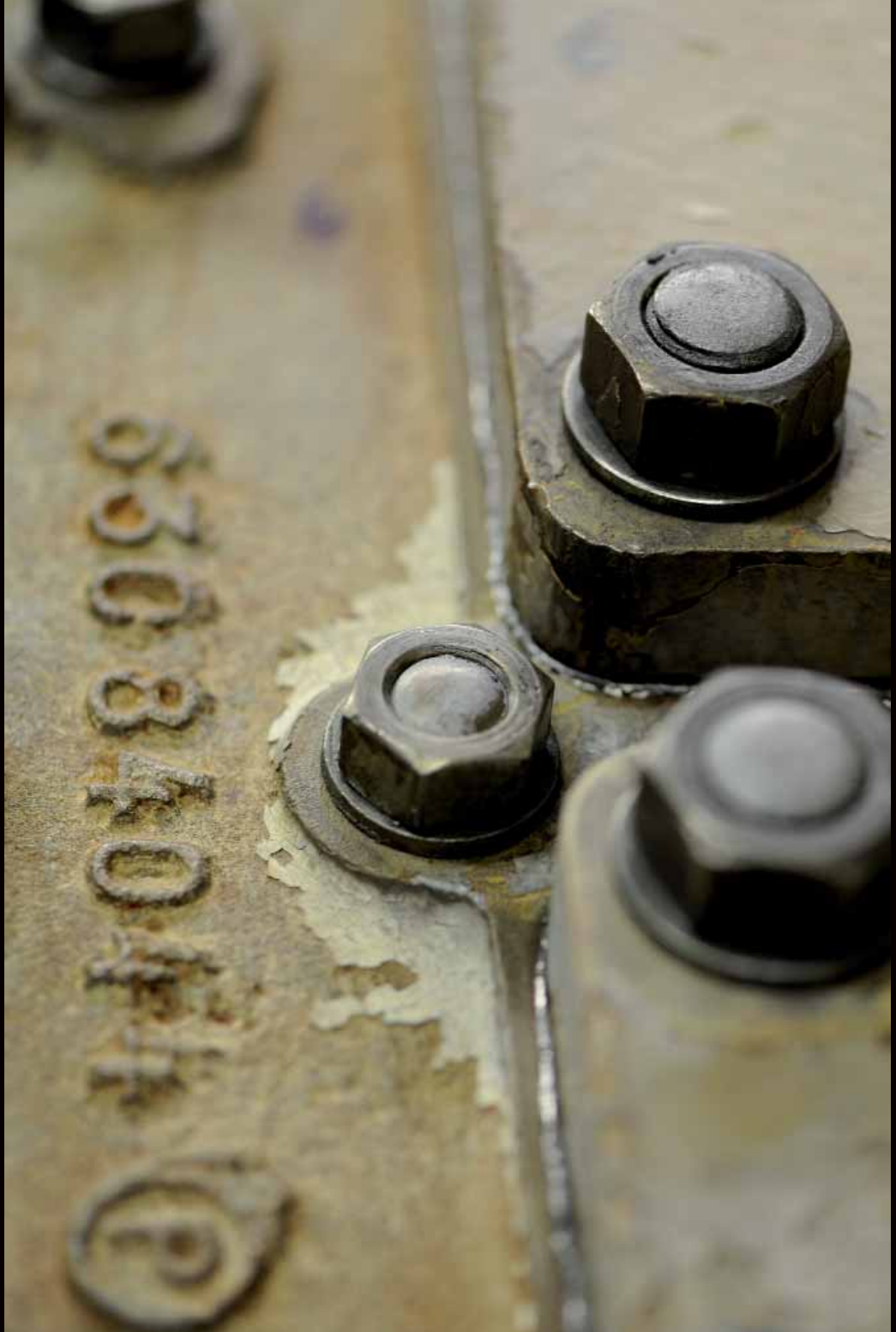
15.40 Uhr, Maschinenhaus: Nahaufnahme der Schraubenverbindungen an den Ventildeckeln des Werkluftkompressors.
