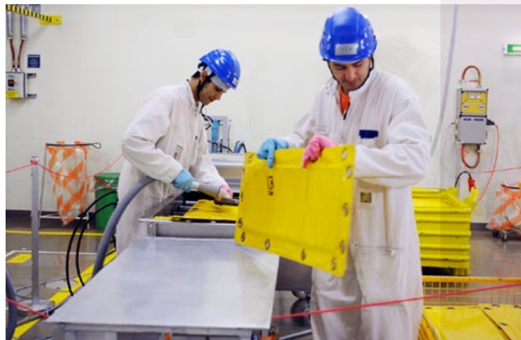
△ Die Bleimatten, die während der Revision zum Schutz vor Strahlung eingesetzt sind, werden anschliessend gereinigt und einzeln auf Kontamination geprüft.
