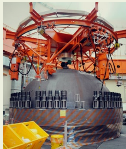
△ Mit einer Anhängervorrichtung, die auch die hydraulischen Werkzeuge zum Lösen der 72 Bolzen beinhaltet, wird der Reaktordeckel abgehoben.
