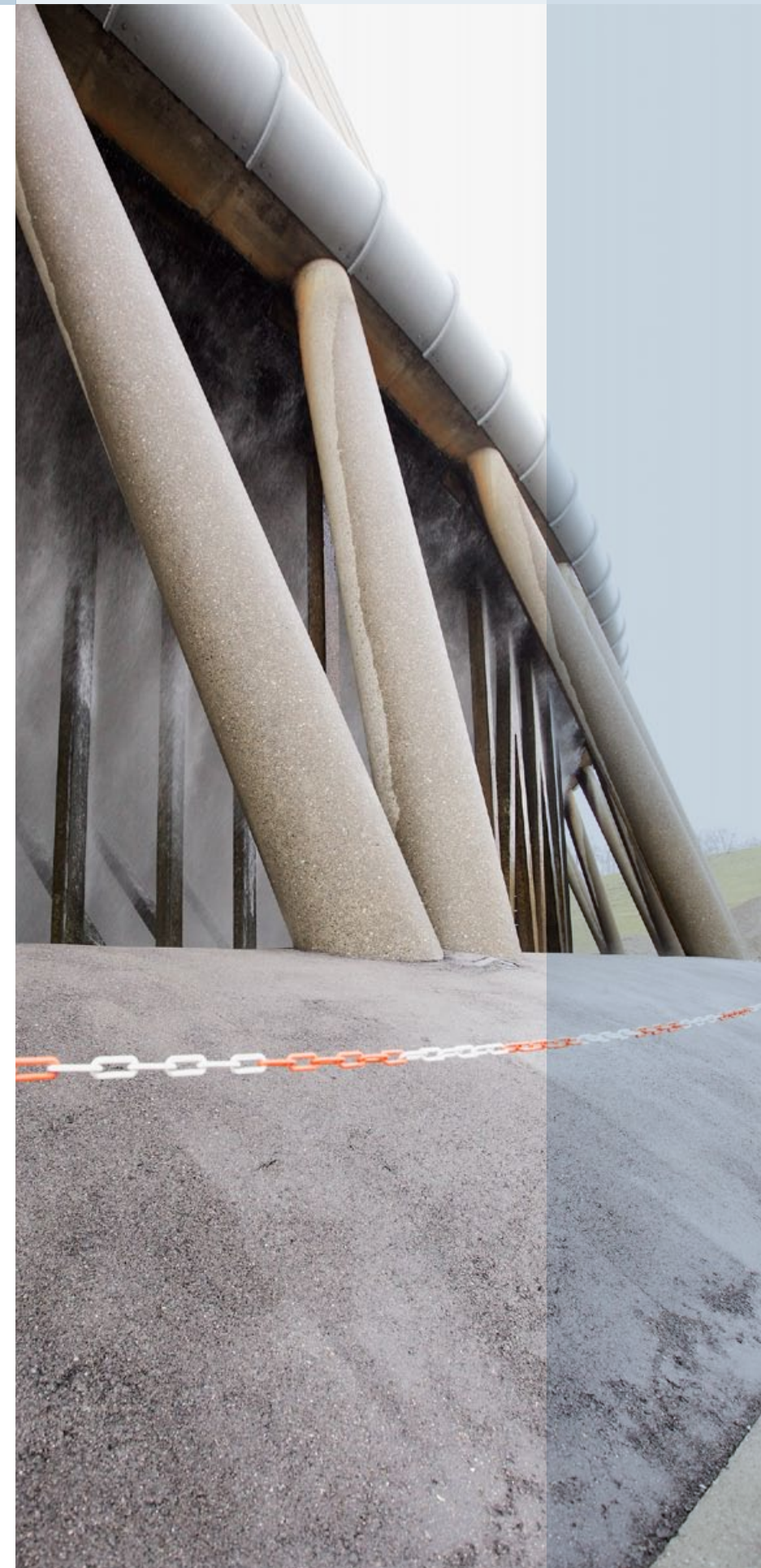
△ Durch den Einbau von abgerundeten Elementen als Einströmhilfen an der Schalenkante des Kühlturmes konnte die Wirbelbildung wesentlich reduziert werden.
