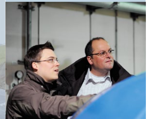
△ Peter Graf zusammen mit einem Projektmitarbeiter beim Rundgang durch das Hauptkühlwasser-Pumpenhaus im Rahmen des innovativen Kühlturmprojektes.
