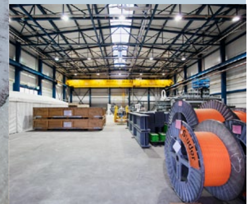
△ Die neue Lagerhalle bietet die Möglichkeit, bei Bedarf rasch auf die nötigen Ersatzkomponenten zuzugreifen.
