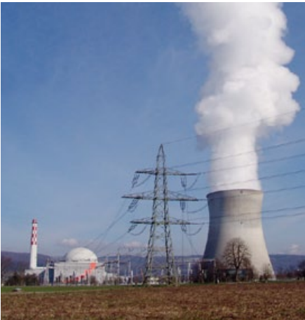
△ Über diese Hochspannungsleitungen führt das KKL täglich Strom für über eine Million Menschen ab.
