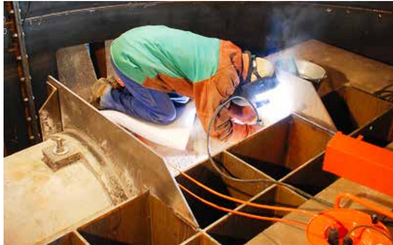
Schweissarbeiten beim Einbau der zwölf Tonnen schweren Bypasszylinder.
