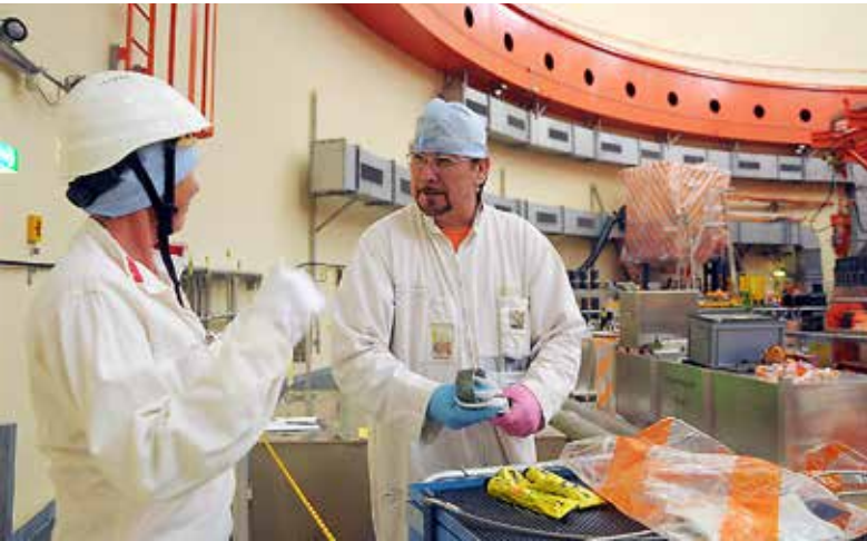
Revisionsarbeiten innerhalb des Containments.
