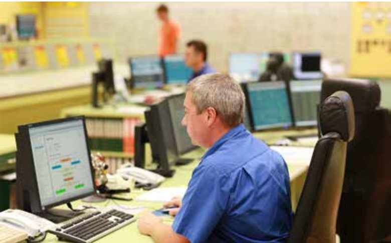
Im Kommandoraum steuern rund um die Uhr und im Schichtbetrieb langjährig ausgebildete Operateure die Kernanlage.
