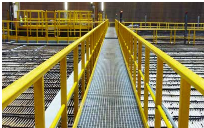
Neu eingebaute Geländer und Stege im Kühlturm.
