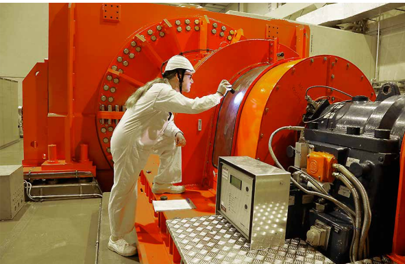
Kontrollarbeiten am Generator werden durchgeführt.
