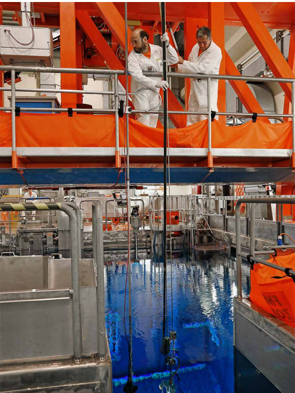
Inspektion mittels Unterwasserkamera im Brennelementlagerbecken.
