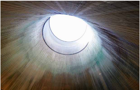
Kühlturm von innen
