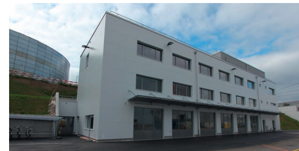
Die neue Elektrowerkstatt wurde in Betrieb genommen.
