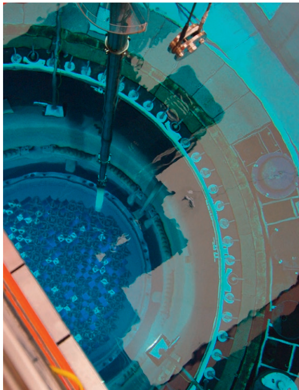
Blick auf die Brennelemente im offenen Reaktor.
