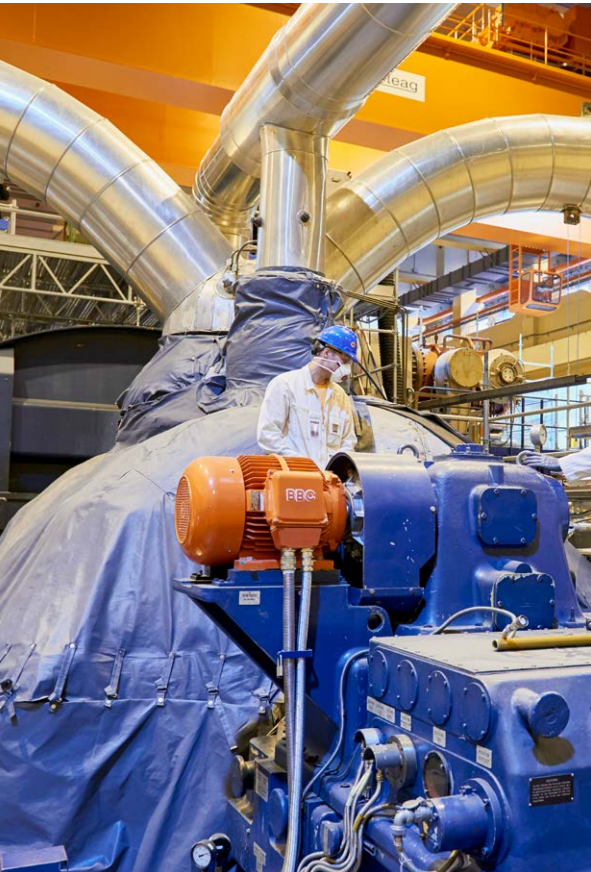
Revisionsarbeiten an der Hochdruckturbine.
