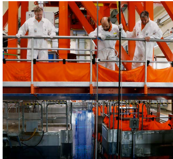
Arbeiten im Brennelementlager.
