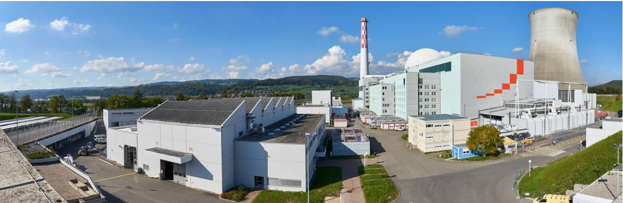
Blick auf die Anlage während der Jahreshauptrevision.
