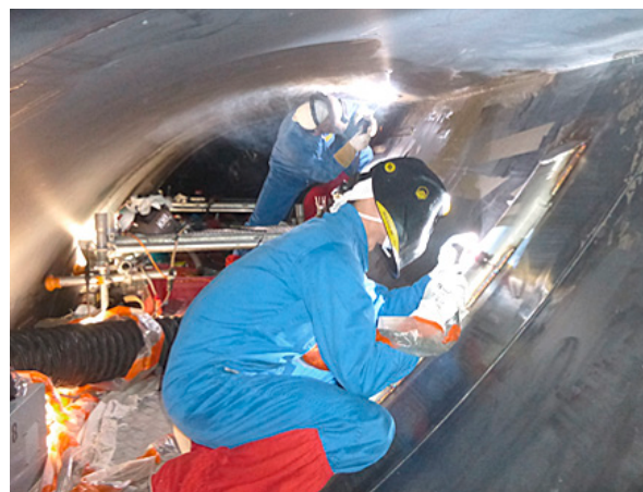
Inspektions- und Garantiearbeiten an den Wasserabscheider-Zwischenüberhitzern
