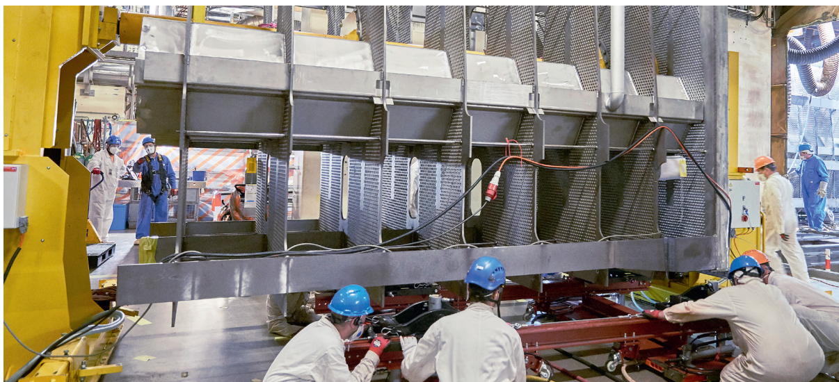
Für die neuen Kondensatormodule wurde eine spezielle Transportvorrichtung konstruiert.
