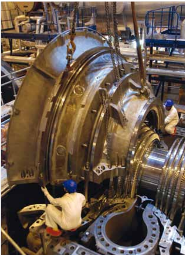
Nach der Wartung wird das Schaufelträgergehäuse wieder auf die Niederdruckturbine montiert.
