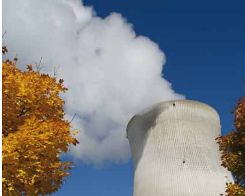
Dem Kühlturm entsteigt reiner Wasserdampf.
